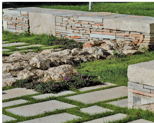
FIG. 13/ Restos de los antiguos muros emergiendo entre los nuevos erigidos con los antiguos materiales de construcción reciclados.
