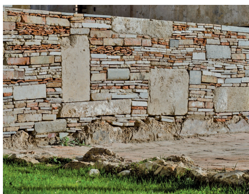
FIG. 9, 10/ Detalle de los muros construidos con los escombros de la demolición del convento aparejados en seco.
