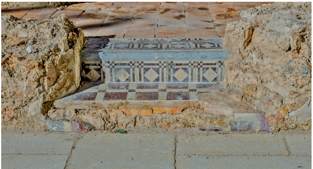
FIG. 17/ Resto de la escalera de acceso a la sacristía con su pavimento de baldosas hidráulicas.
