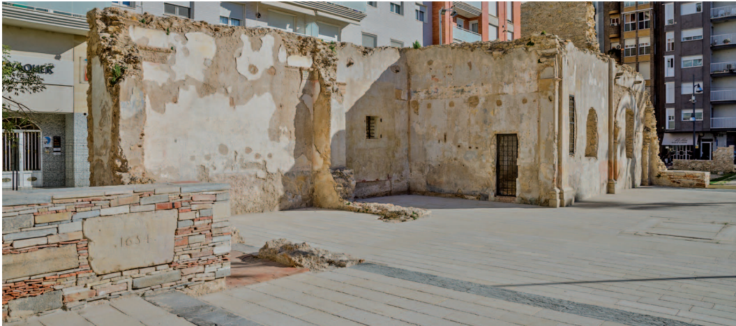
FIG. 11/ El muro remanente de la iglesia una vez restaurado
